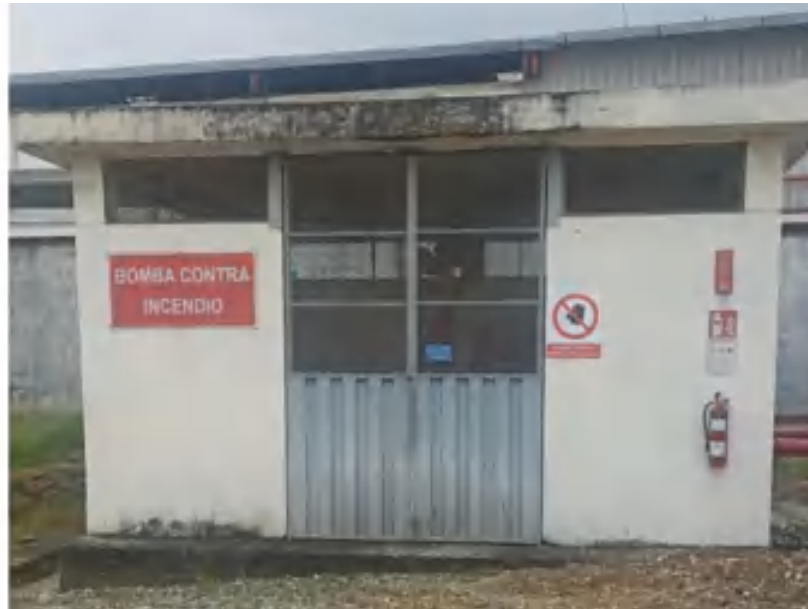
Fotografía 31. Área sistema contra incendios
