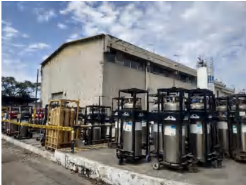
Fotografía 12. Antigua Planta Asu
