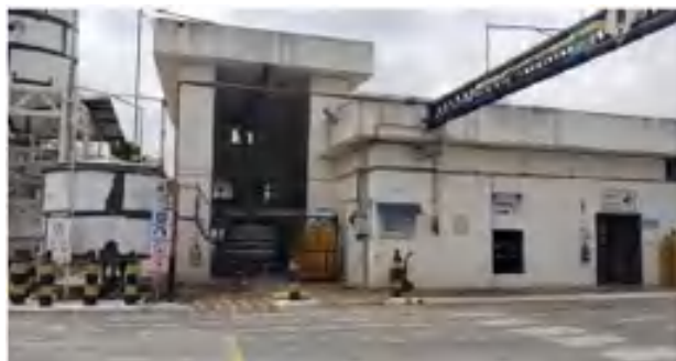
Fotografía 3. Planta de producción de acetileno
