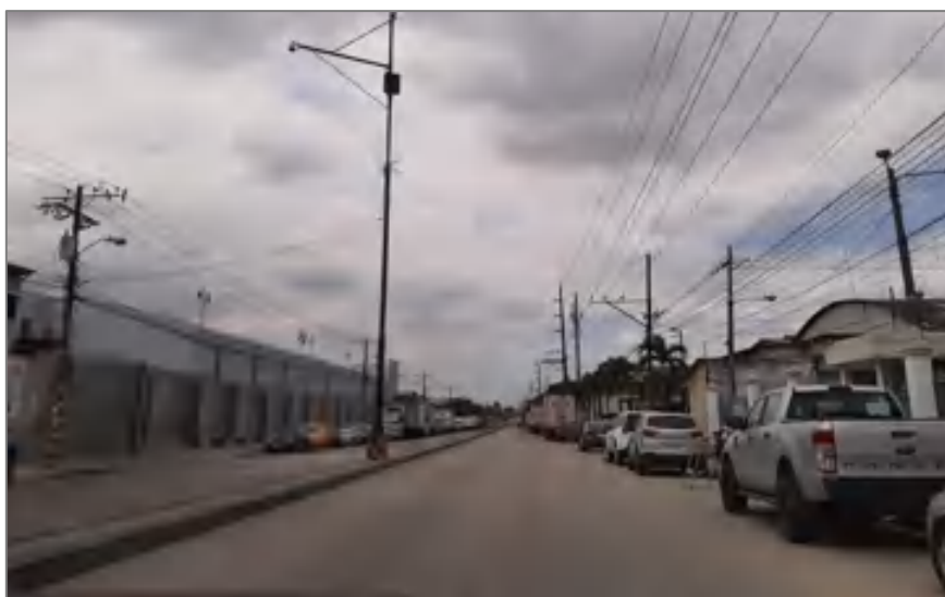
Fotografía 5.- Aspecto de las vías circundantes a la Planta (Av. 42 N-O)
