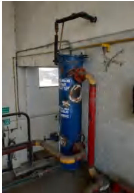
Fotografía 33. Producción de acetileno - Enfriamiento
