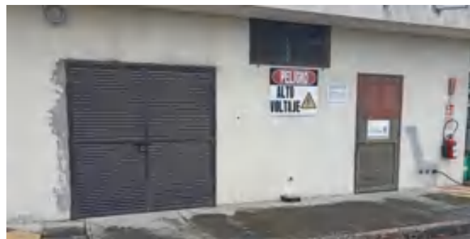
Fotografía 28. Área del generador de emergencia
