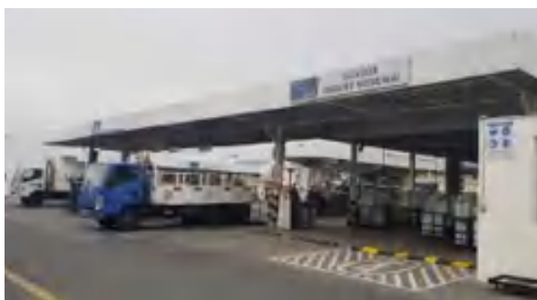
Fotografía 8. Estación oxígeno medicinal
